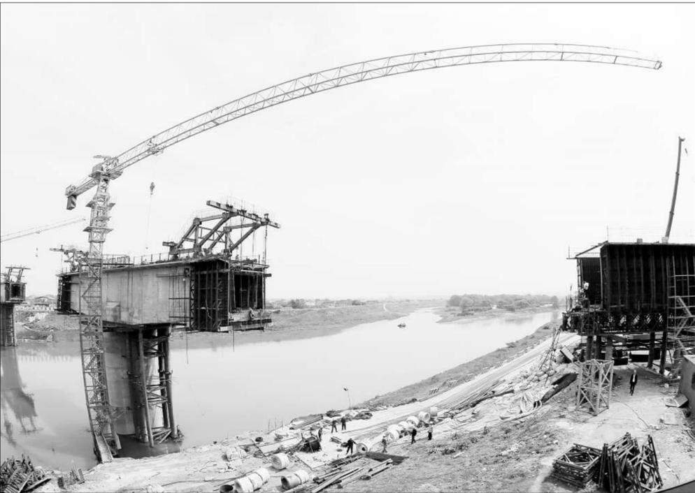
由中国铁建股份有限公司按照EPC模式实行设计施工总承包,中铁十六局集团等承建的长沙磁浮工程为我国首个具有自主知识产权的中低速磁浮轨道交通项目施工进度顺利。该工程是湖南省、长沙市的重点工程,项目西起长沙南站,东至黄花机场,线路全长18.519km。图为中铁十六局集团在浏阳河特大桥主跨(85+110+85)m连续梁采用挂篮悬臂法施工,为全线唯一一座采用挂篮施工的连续梁。 成海忠 台玉琼摄
