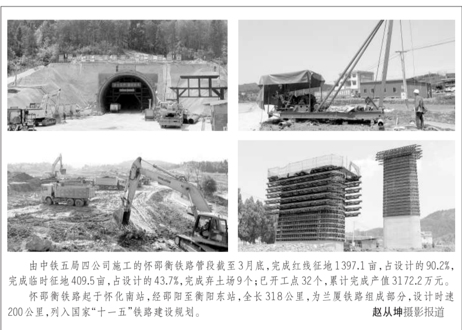
由中铁五局四公司施工的怀邵衡铁路管段截至3月底,完成红线征地1397.1亩,占设计的90.2%,完成临时征地409.5亩,占设计的43.7%,完成弃土场9个;已开工点32个,累计完成产值3172.2万元。
