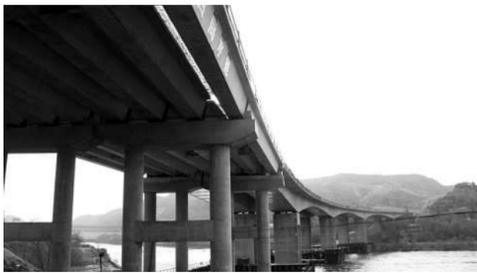
记者15日了解到,由中铁四局七分公司兰(州)永(靖)快速通道4标项目施工的盐锅峡黄河大桥为钢构连续组合桥,全长471.5米,位于盐锅峡水电站大坝下游900米处。河道高峰期水流量每秒达1900立方米,项目均采用“钓鱼法”和“植入法”相结合的施工工艺,成功破解了栈桥搭设难题。该大桥预计于今年6月底前建成通车。(朱旭 滕继濮)
