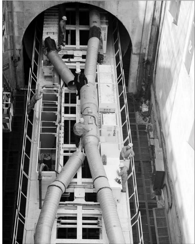
4月16日,施工人员在调试掘进机。当日,由中铁隧道集团负责施工的青岛地铁2号线一标段实现硬岩掘进机(TBM)顺利始发。这是我国首次将TBM施工技术运用于地铁建设。新华社记者 张宇摄
