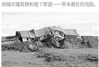
图由于叶尼塞河冰雪消融而导致的房屋坍塌。叶尼塞河是流向北冰洋的最大河流系统。
