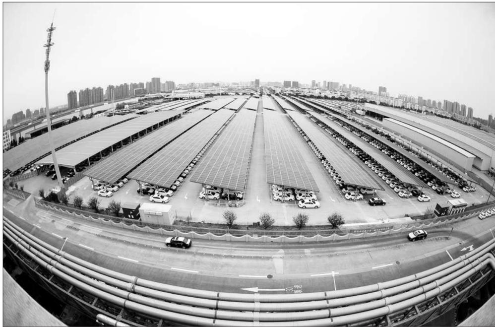
3月26日,位于江苏南京江宁区上海大众汽车南京分公司厂内的光伏车棚作为全球装机容量最大的光伏建筑一体化电站,被颁发吉尼斯世界纪录证书。据南京电力部门介绍,该光伏车棚总面积约20万平方米,装机容量达10.213兆瓦,最多可同时停放4000多辆轿车。该光伏车棚于2013年底建成投运,至今累计发电1413万千瓦时,上网电量22万千瓦时,相当于节约标煤5652吨,减排二氧化碳等有有害气体排放约1.4万吨。
