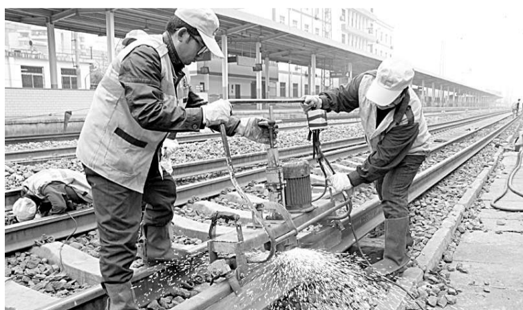
连日来,西安局管内陇海、宝成线集中修施工正酣,西安工务机械段党委针对施工安全重点、难点、薄弱点及关键作业,及时调整党员“岗区”设置,明确“岗区”控制范围,确保安全关键岗位有党员干、有党员盯,为施工安全开展提供保障。图为该段党员技术骨干对钢轨接头进行打磨修整作业。 邵旭华摄影报道
