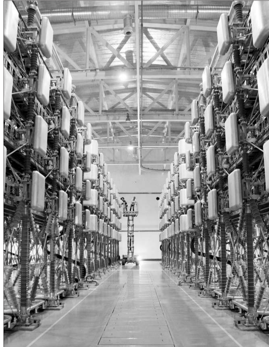
3月17日,世界首个五端柔性直流输电工程——浙江舟山±200千伏五端柔性直流输电示范工程历时5天,顺利完成投运以来最大规模的系统检修。为柔直工程健康稳定运行打下了坚实基础,也为清洁能源并网、海上风电送出等应用铺平了道路,给力争“一带一路”战略支点的舟山“江海联运中心”提供坚强的智能化电能保障。
