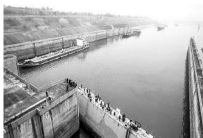
中国长江三峡集团公司三峡枢纽建设运行管理局3月13日透露,三峡南线船闸2015年计划性停航检修施工任务已按计划完成,并通过了由业主、设计、监理、运行、施工等单位专家的联合验收,恢复通航。图为工人将三峡南线船闸下游用于检修的挡水浮门运出作业区,以便通航后船舶通行。新华社发(郑家裕摄)
