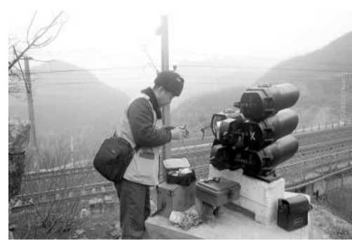
春运期间，郑州铁路局新乡电务段加强信号设备的维护和检修，为确保列车安全运行准确导航。图为该段职工在大焦线孔庄测试信号机数据。(李静)
