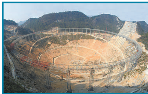
圆梁安装过程③
