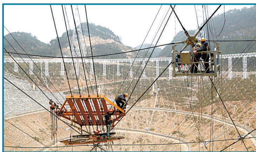
2015年2月4日,FAST索网安装工程合龙,图为工人正在安装最后一根钢索。
