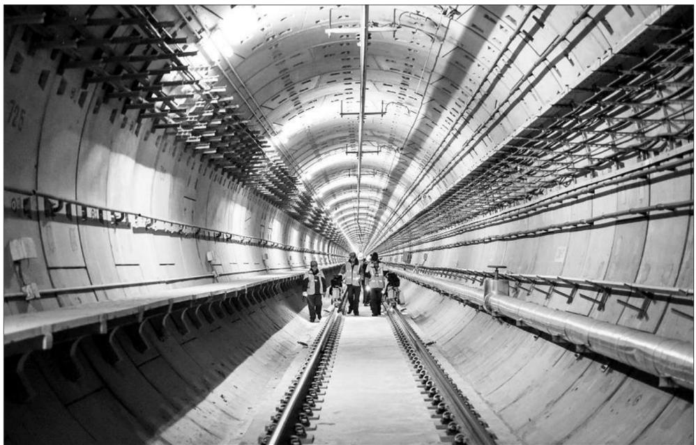
每一个深夜,在北京的地铁隧道中,都有一群人在幽深寂静的隧道中行走,他们有一个特殊的称呼“探伤工”——为地铁铁轨探伤。按照计划,每天向前推进的四公里“钢轨母材”探伤工作雷打不动,而这四公里,全都要靠探伤工们用眼睛和脚步,细心的一点一点检测完,对探伤仪上显示出来的每一个回波信号,都要进行仔细甄别和分析,对重要疑点处则要要进行明显的标记和记录,保障后续跟进检查或处理。日复一日,年复一年,从上班之日起,探伤工们就在这样“黑白颠倒”的生活里,为地铁的安全运行做着自己的贡献。图为地铁“探伤工”在北京地铁14号线东段的地铁隧道内进行钢轨母材探伤工作。
