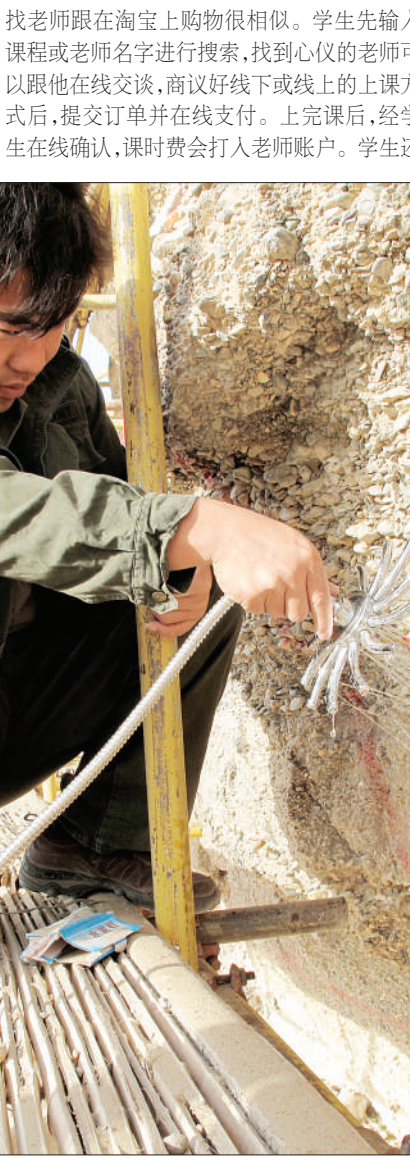
土遗址是我国文化遗产中最为普遍的遗址类型,由于工艺脆弱和病害发育,亟待保护。在国家科技支撑计划的支持下,敦煌研究院经过8年的潜心研究,开发出“干旱环境下土遗址保护加固集成技术”,首次科学揭示土遗址病害的形成机理与演化模式,研发了系列土遗址无机保护加固材料和工艺,开展加固机理、环境适应性及耐久性评估研究。张焯摄
