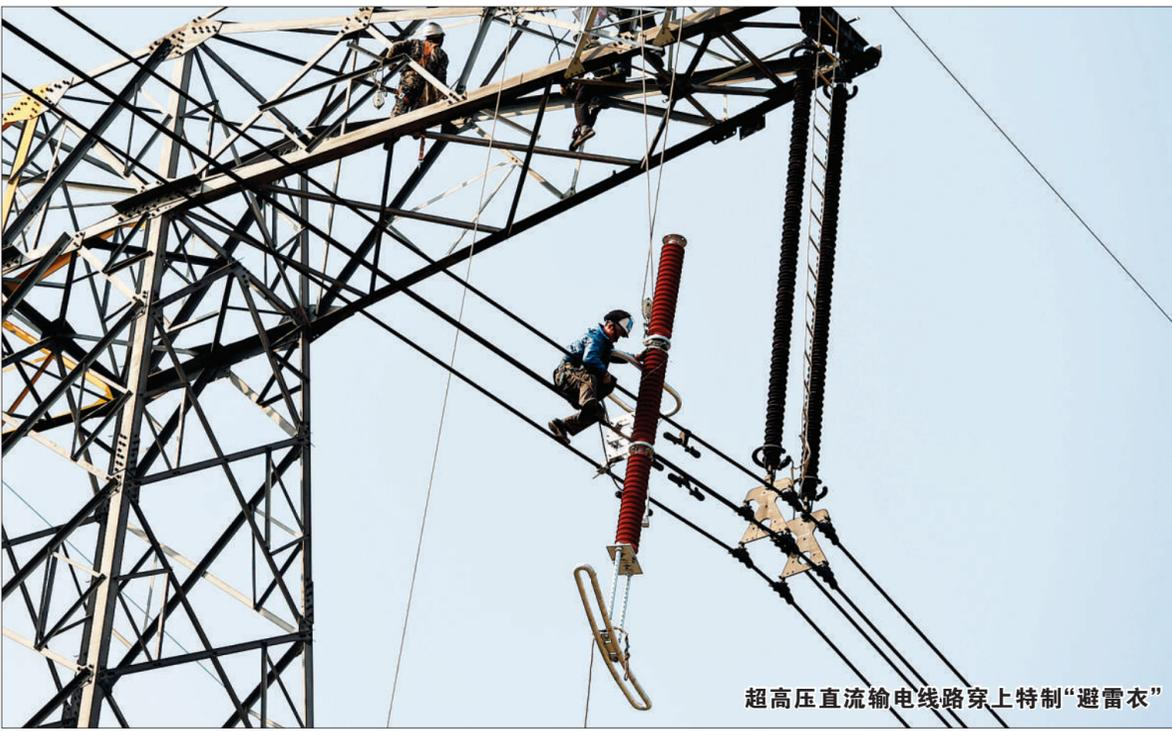
超高压直流输电线路穿上特制“避雷衣”
