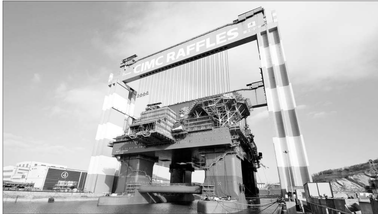
1月19日,由中集来福士为挪威一公司建造的北极海域半潜式钻井平台“维京龙”号上下船体在中集来福士烟台建造基地成功合拢。“维京龙”号是烟台建造的第一座可在北极海域作业的半潜式钻井平台,依照挪威北海和北极圈内巴伦支海海况设计,平台工作水深500米,最大钻井深度8000米。新华社发(唐克摄)
