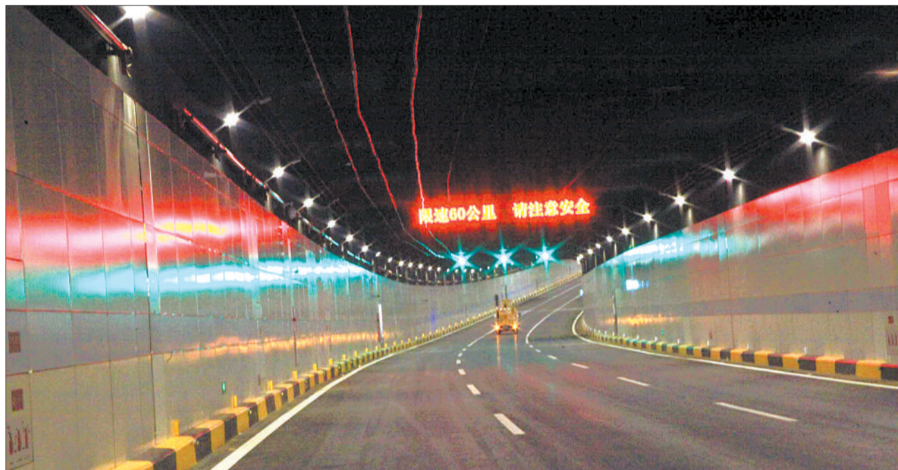
画中有话 由天津滨海新区投资、中国铁建十八局集团承建的国内首座高震区水下沉管隧道——天津市滨海新区中央大道海河隧道,1月18日全面建成。该工程创造6项国内之最,荣获22项国家专利和9项国家级奖励。 陈仕奇 伍振 龙艳摄
