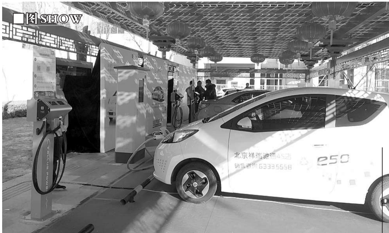
1月19日,位于北京华贸中心的富电科技充电站落成并开放。充电站首期100台充电桩,包括2座地面光伏智能充电站和地下超级智能充电站,光伏组件转换效率为22%。充电站将提供智能化、网络化、远程化服务,用户可通过手机APP预约充电和付款。据悉,为推广新能源汽车,北京市对充电设施建设运营采用自由竞争、公平开放的市场准入原则,鼓励社会各方资本参与充电设施建设与运营。
