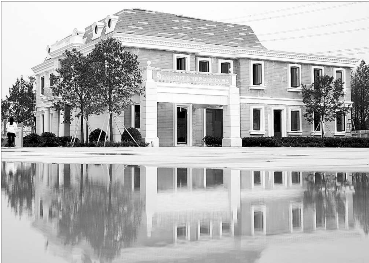
近日,数幢使用3D打印技术建造的建筑亮相苏州工业园区。这批建筑包括一栋面积1100平米的别墅和一栋6层居民楼。这些建筑的墙体由大型3D打印机层层叠加喷绘而成,而打印使用的“油墨”则由建筑垃圾制成。图为两名行人从3D打印制成的别墅旁经过。
