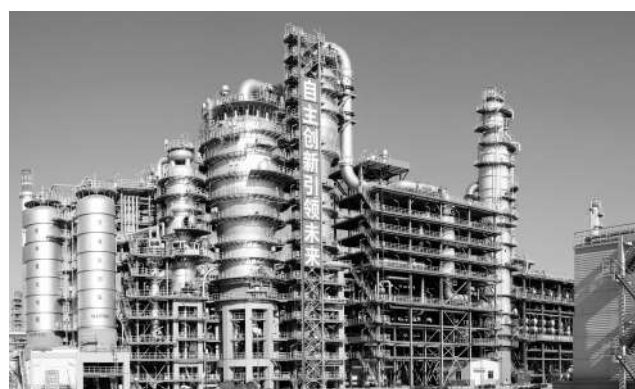
神华包头180万吨煤基甲醇制60万吨烯烃项目
