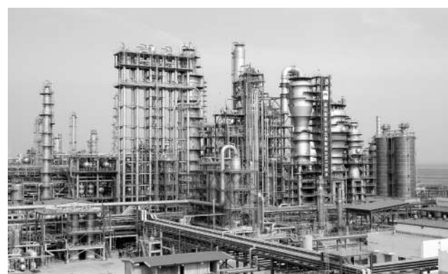
宁波不元180万吨甲醇制40万吨聚丙烯、50万吨乙二醇项目
