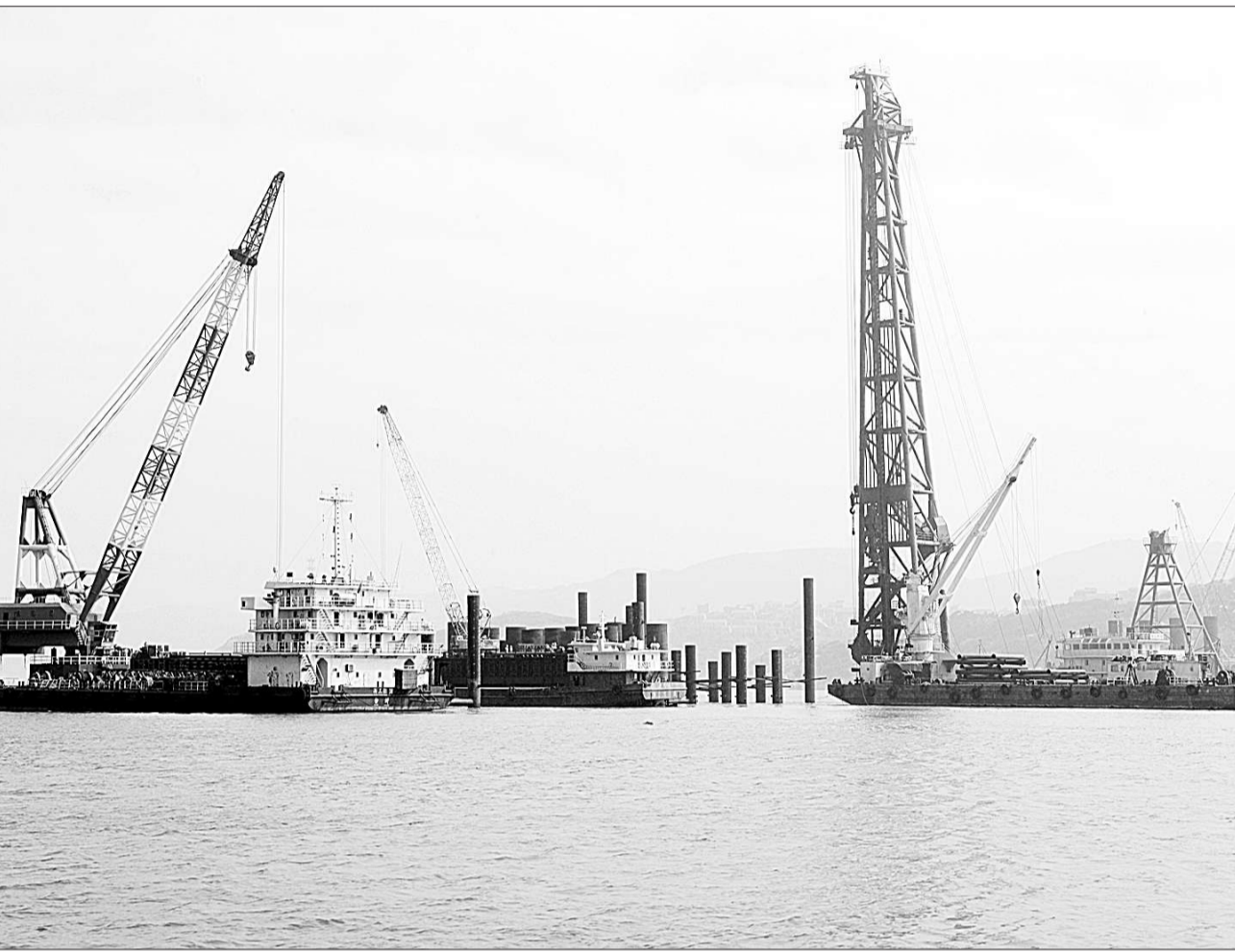
国家重点工程——平潭海峡公铁两用跨海大桥自2013年11月动工建设以来进展顺利。平潭海峡公铁两用跨海大桥为钢桁结合梁斜桥,全长16公里,采用双层桥面,下层为双线铁路,设计时速为200公里,能跑动车组;上层为时速100公里的六车道高速公路。大桥总投资约240亿元,预计在2019年建成通车。
