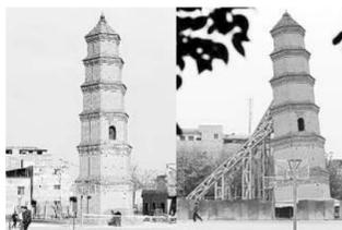
近日,历经一年多的西安万寿寺塔偏修工程完成,曾经倾斜达2.64米的万寿寺塔已改“斜”归正。由于初建时夯土不实、周围古墓穴相继坍塌、塔体周围地基含水量过高,曾在塔附近开挖防空洞等原因导致其倾斜。万寿寺塔始建于明万历年间,距今400多年,塔高22米,共6层。图为完成纠偏“手术”的万寿寺塔(左)与之前倾斜状态(右)的对比。
