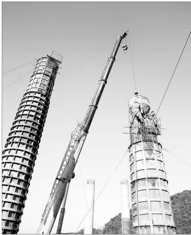
中国铁建十六局集团路桥公司在省道204线福建省顺昌五(里亭)将(乐界)公路改建工程严格执行工程质量“三检”制度,从人、材料、机械、施工方法和环境5个影响质量因素入手,促进工程进度。图为职工在横跨超富屯溪和鹰厦铁路的埔上大桥工地浇筑桥墩情景。方木摄
