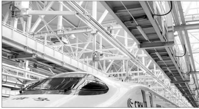
北京铁道所自主研发的侧式接触网
