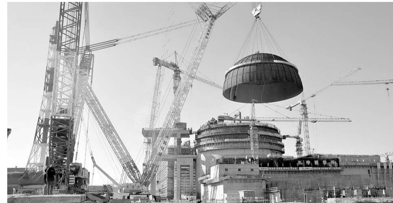
田湾核电站3号机组穹顶整体吊装现场 黄磊/摄
