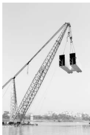
上图:英华大桥俯瞰;左下图:吊装;右下图:500吨浮吊吊装
