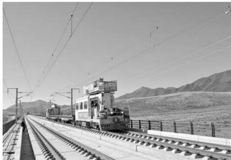
中铁电气化局作业车在兰新高客专进行架线施工。 胡斌摄
