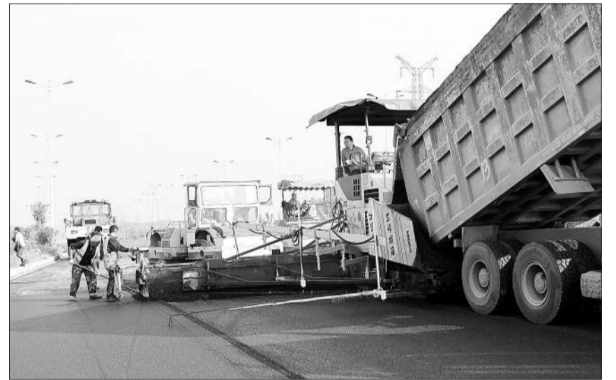
由中国铁建十六局路桥公司承担施工的南昌小微工业园建园大道、小微大道,自开工以来,项目部优化施工方案、合理安排工序、狠抓工程安全质量、细化物资管理,确保了道路各项配套设施稳步有序向前推进。目前,道路排、污、水、强、弱电、绿化等工程已全部完工,现在正在进行道路沥青面层施工冲刺阶段,为年度前实现交验奠定基础。黄洋洲摄
