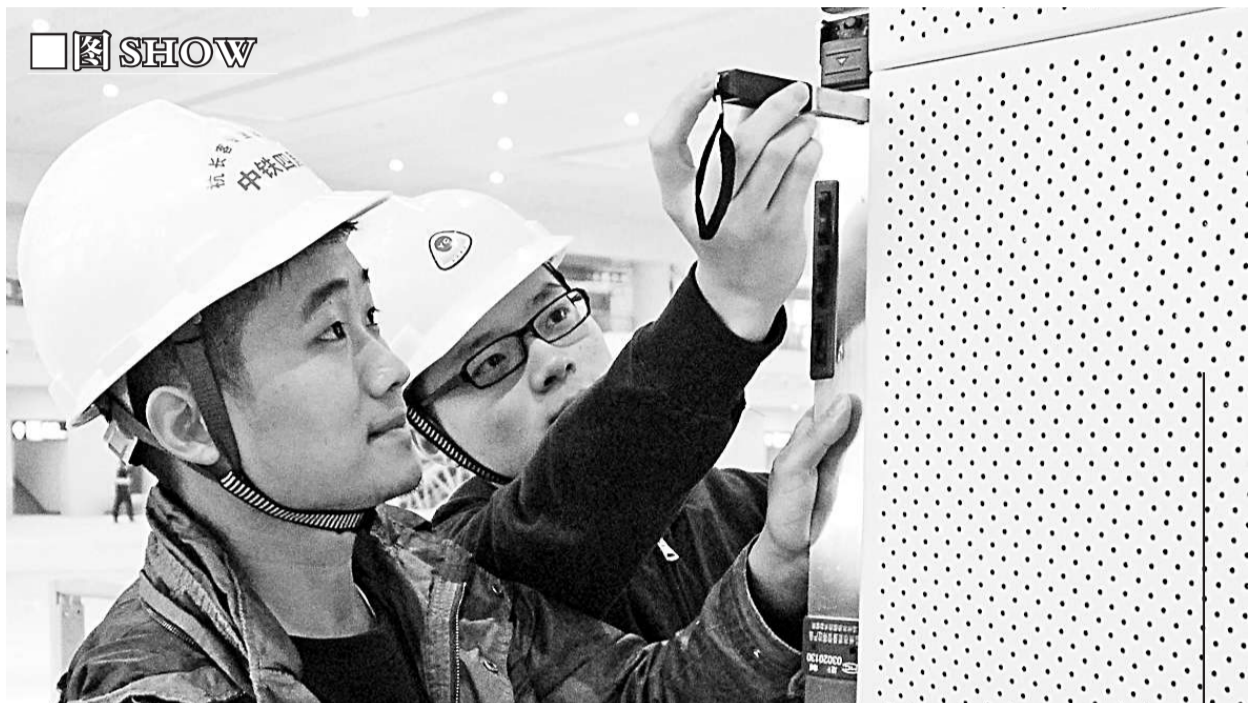
中铁四局建筑公司在承担的30个工程项目施工中,积极结合企业特点应用新材料、新技术、新工艺,致力建设科技、环保、效益型项目,促进了管理的提升,今年以来交验的13项工程均实现一次通过。图为该公司在建设中的杭长高铁金华西站内墙装修中第一次采用穿孔铝板材料技术,技术人员在检查隔音、环保以及安装质量等效果。 方成龙摄
