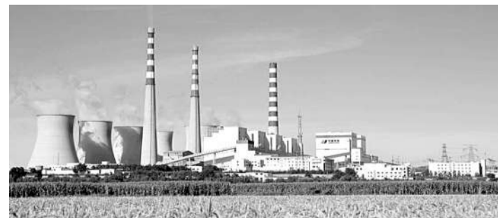
华电铁岭电厂脱硫低省项目
