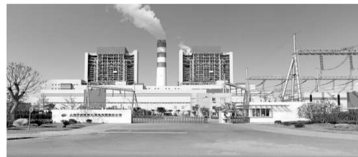
上海外高桥电厂脱硫项目
