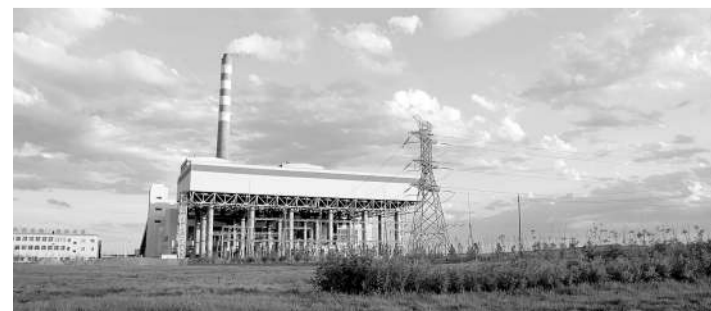
和丰电厂脱硫运维总包项目
