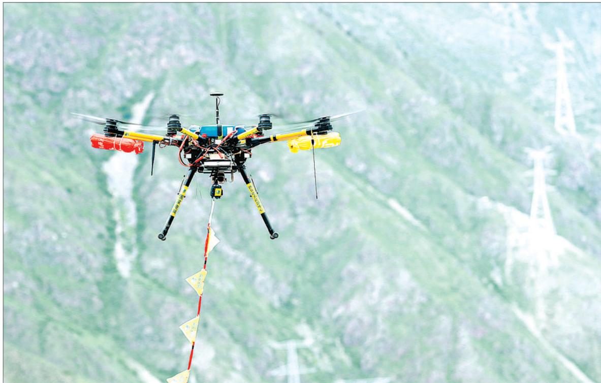
国家电网的遥控飞机在四川巴塘县进行空中架线(8月3日摄)。11月20日,川藏电力联网工程正式投运。
