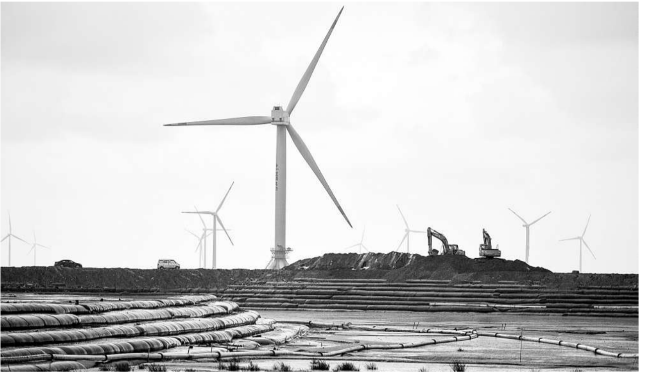
11月8日,挖掘机在南通刘埠渔港海堤上施工。当日,位于江苏南通如东县的国家一级渔港——刘埠渔港工程正式开工。据介绍,刘埠国家一级渔港建设规划总投资约10亿元。建成后,该渔港可同时容纳1000艘渔船避风、卸鱼、补给、维修,最大可通行650马力的渔船,年卸鱼量可达5.5万吨。
