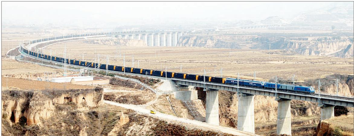
11月6日,随着满载1.2万吨煤炭的J55001次试验列车驶入山西省长治市平顺站,这标志着我国第一条按照30吨轴重重载铁路标准建设的铁路已经建成。图为1.2万吨的重载列车运行在山西中南部铁路通道壶关至平顺间的路段上。
