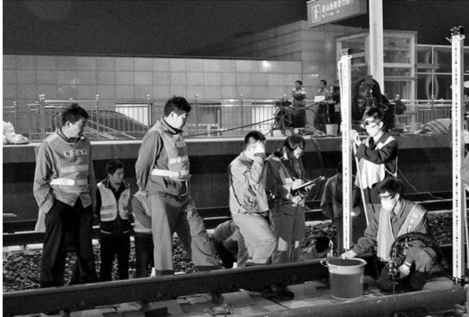
高速铁路无砟轨道线路开通运营后,由于施工预压期短、地下开采、交叉工程施工、周边环境变化、区域沉降等因素的影响,部分线路地段出现不均匀下沉现象。在沉降量较小时,一般通过调整线路钢轨扣件达到线路顺坡来满足列车的运行要求,但随着沉降的发展,为确保行车安全,必须在扣件调整能力达到极限前采取有效的措施,保证线路的平顺性。隧道内整体道床下沉或翻浆冒泥病害也是一种常见病害,过去常用的整治方法是架空线路凿除下沉或破损整体道床后重新浇筑,该方法工期长、效率低、安全风险大,列车需长期慢行,严重影响正常运输秩序。鉴于上述两种情况,急需研究一种快速、高效、安全风险低的新技术来解决这些问题。“注胶法整治无砟轨道道床下沉技术研究”就是针对此现状而研发的。
