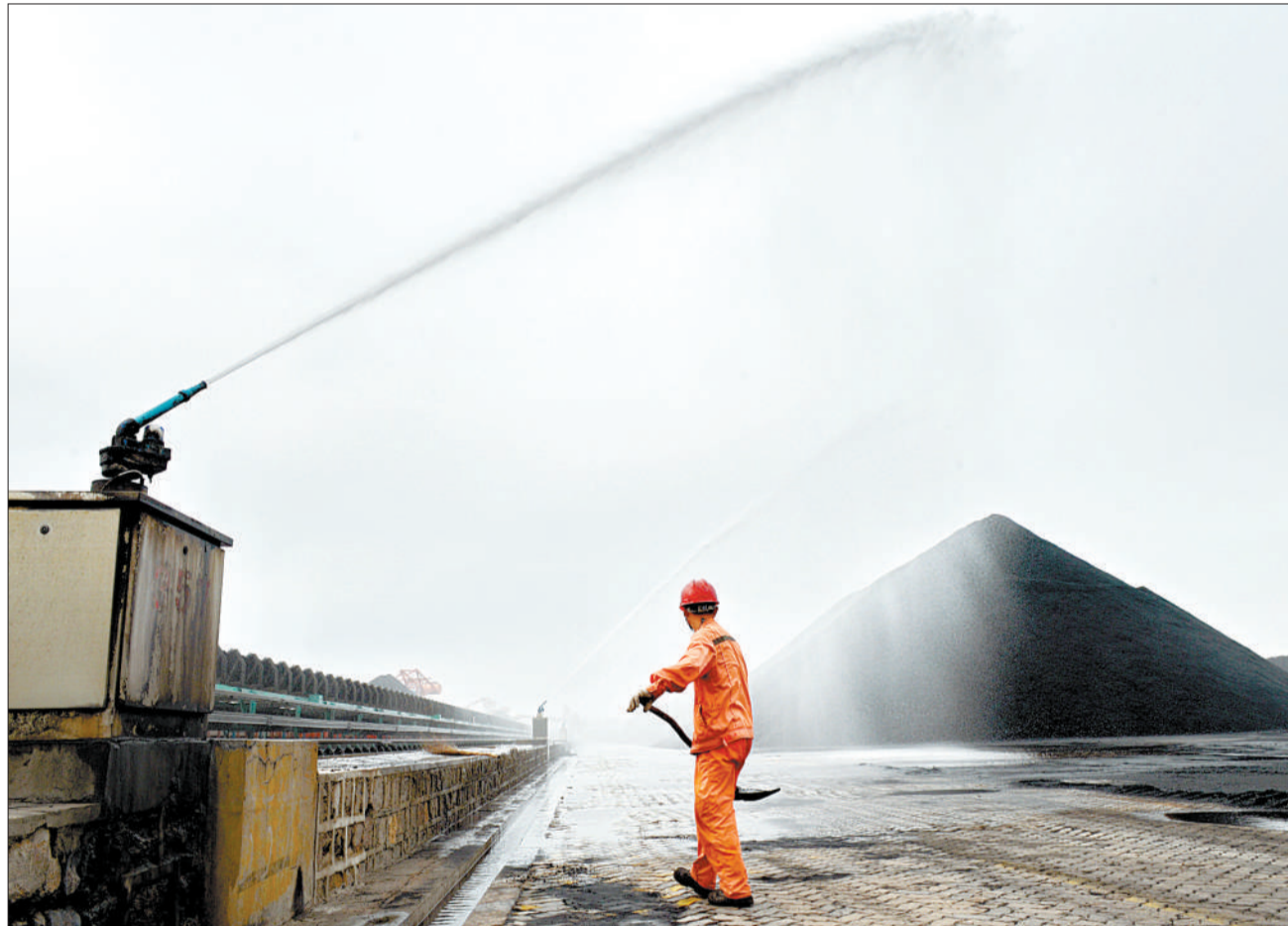
河北黄骅港是我国北方重要的煤炭输出港口。2010年以来,黄骅港以建成绿色枢纽、生态良港为目标,投入巨资治理煤炭污染。通过引入封闭筒仓储煤工艺,完善煤场喷淋设施,建设抑尘防风网等多项措施,有效减少了煤炭粉尘污染,提升了港区的环境质量。新华社发(李宇摄)
