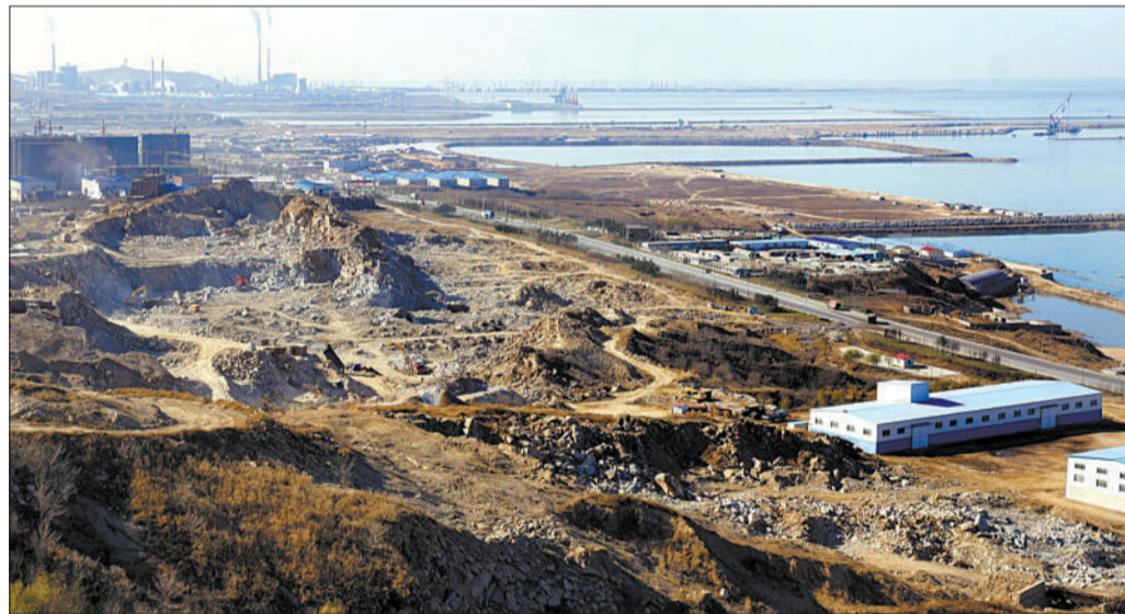
黄渤海的大规模围填海工程。
