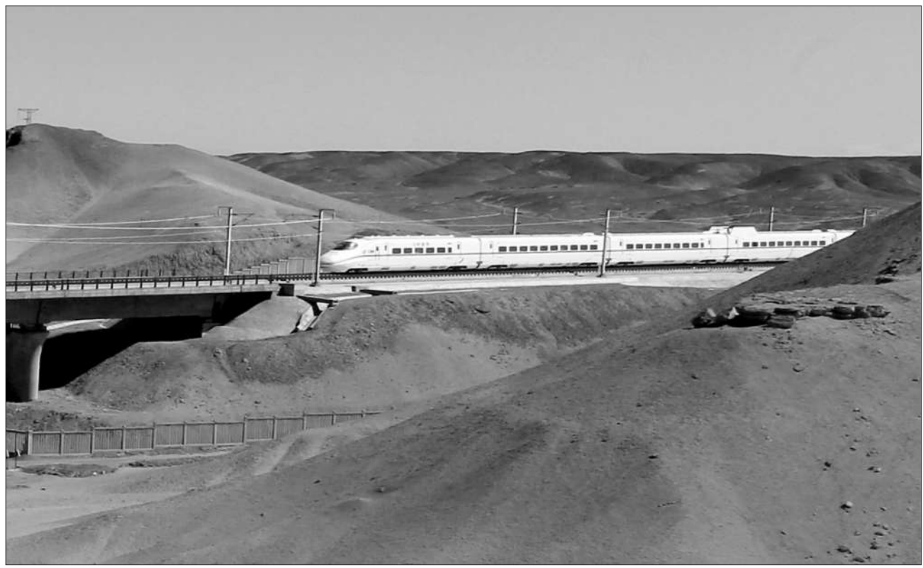
日前,兰新高铁乌鲁木齐至哈密段试运行结束,标志着该段高铁已进入通车前的最后准备阶段,预计10月开通运营。兰新高铁横贯中国西北的甘肃、青海、新疆三省区,是中国首条在海拔地区修建的高速铁路,预计今年年底全线通车。图为一列动车在兰新高铁新疆哈密戈壁地段疾驰。 新华社发(蔡增乐摄)
