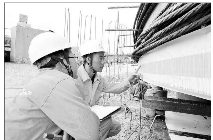
9月10日下午,经过1个小时的缓慢转动,矗立在沪昆铁路沾益火车站两侧、重达8300吨的两段“巨无霸”桥梁,向跨越的沾益火车站平转25.3°,实现桥梁精准合龙。沾益特大桥是沪昆高铁云南段的控制性工程。 新华社记者 潘浩摄
