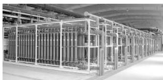
依托于天津膜天膜科技股份有限公司的天津市膜技术与水资资源化工程企业重点实验室采用当前国内最先进的“水解酸化-絮凝-沉淀-连续微滤-反渗透”深度处理工艺,在天津荣程联合钢铁集团有限公司设计了日处理72000吨的双膜法深度处理回用系统,在全国冶金行业率先实现地下水零开采、污水零排放。
