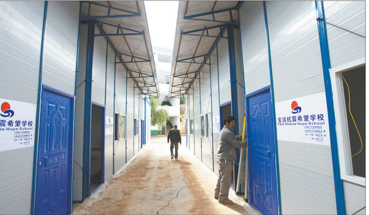
8月25日,在云南省巧家县包谷塘乡抗震希望学校,施工工人为新建的活动板房安装照明、供水等附属设施。目前,鲁甸地震灾区云南省巧家县包谷塘乡抗震希望学校活动板房已搭建完毕,配发的700余套新桌椅基本到位,准备迎接开学。新华社发(张广玉摄)
