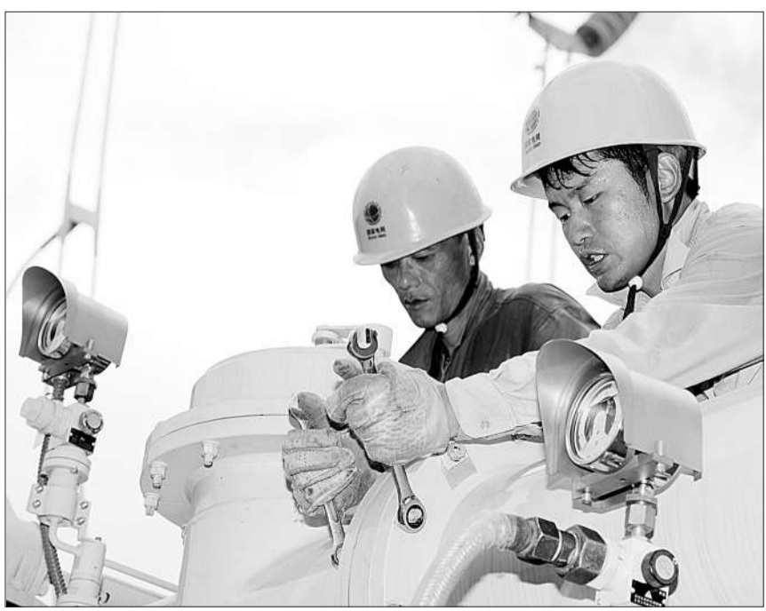
进入7月来,浙江多地最高气温超过35℃。浙江电网调峰最高负荷达到5409万千瓦,创浙江今年调用电负荷新高。据预测,今年迎峰度夏期间,浙江调峰最大用电负荷需求预计达6100万千瓦,同比增长11.7%。随着特高压工程的先后投运,浙江外购电力将达到1800万千瓦左右,全省电力供需基本平衡。图为在浙江绍兴220千伏九里变电站,国网绍兴供电公司员工在高温下对变电设备进行改造。新华社记者 韩传号摄
