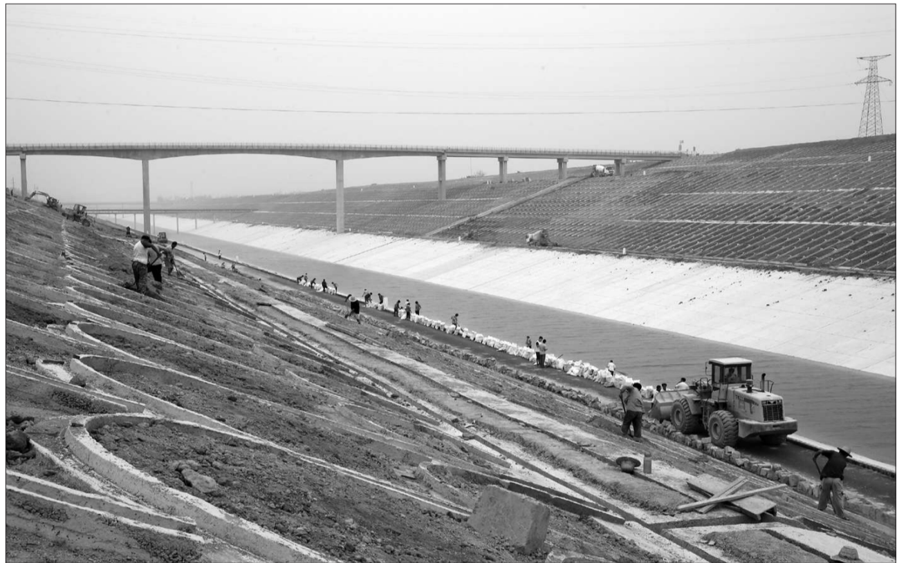
日前，南水北调中线全线已进入充水试验阶段。南水北调中线工程从丹江口水库陶岔闸引水，经长江流域与淮河流域的分水岭方城垭口，沿南水北调中线工程黄淮海平原西部边缘开挖渠道，在河南郑州市附近通过隧洞穿过黄河，沿京广铁路西侧北上。图为中铁十六局集团南水北调中线浙川段施工2标职工正在清理渠道，为全线充水试验做最后的准备工作。
