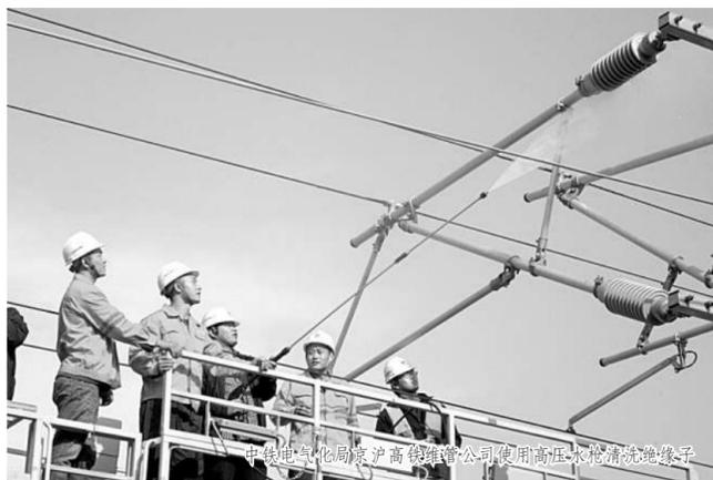
中国中铁电气化局京沪高铁维管公司使用高压水枪清洗绝缘子
