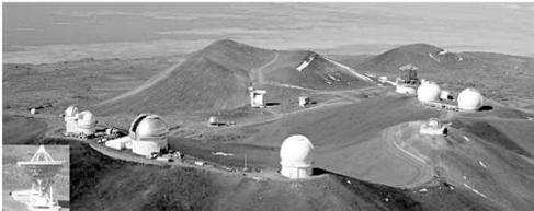
莫纳克亚天文台现有13台正在工作的望远镜,能观测从毫米波到光学波段的天体辐射。目前4台口径超过8米的大型光学望远镜在此落户。
