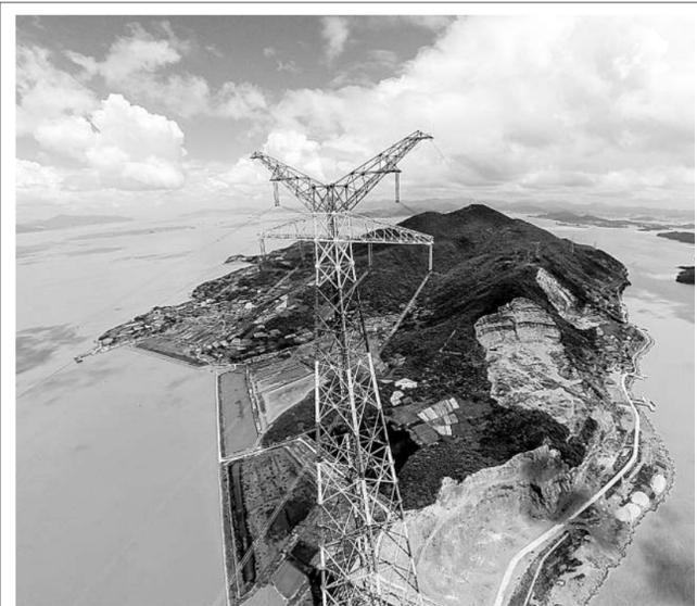
7月31日,浙江省舟山供电公司在舟山市大猫山岛370米高的输电铁塔上完成了浙江首套输电线路光电光路监控系统升级改造。这座高达370米,重达5999吨的输电铁塔是目前国内最高、最重的跨海输电铁塔,同时也是220千伏舟山—大陆跨海联网输电工程的重要一环。图为舟山市大猫山岛370米高的输电铁塔。新华社记者 徐昱摄
