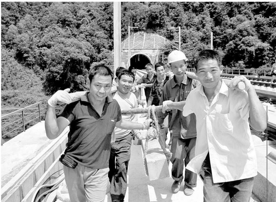
贵广高铁是我国西部大开发战略实施中的一条连接祖国西南内陆与华南珠江三角洲经济带的重要客运专线。日前,贵广高铁三江段已全面完成轨道铺轨任务,工程已进入四电安装、安装隔离栏及清理工程垃圾等扫尾阶段,全力确保工程于年底如期贯通。图为施工工人冒着酷暑在贵广高铁三江侗族自治县高基乡江口村铁桥路段抬运隔离栏水泥柱。
