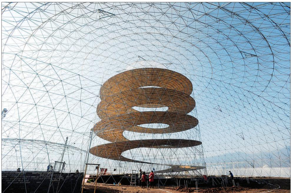
1月16日,在浙江省绍兴市上虞区丰惠镇三溪村,工作人员在建设螺旋式无土栽培蔬菜基地。这种新型栽培基地主体设施高24米,建筑面积3600多平方米,利用喷雾装置将营养液雾化直接供给植物根系。 (新华社发(韩坚摄))
