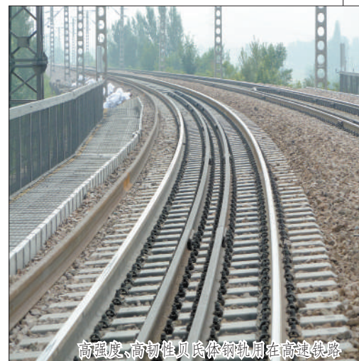
高精度、高韧性贝氏体钢轨用在高速铁路
