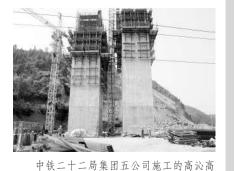
速公路沁水河特大桥桥长1347米,针对该桥 主墩为空心薄壁墩的难点,建设者采用爬模 施工,同时在竖肋上增加三角支架及护栏,并 搭设木板作为施工平台,四周用防护网围护, 从而保证了大桥施工的安全质量。
