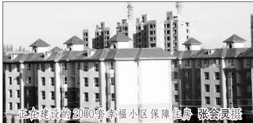
正在建设的2000套幸福小区保障住房 张会灵摄
