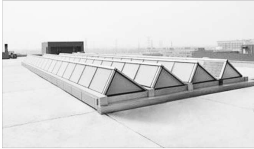
海林低碳节能科技办公楼太阳能屋顶
